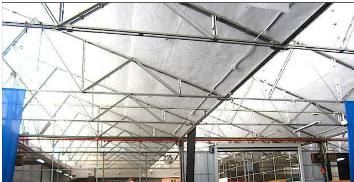
Detalle de las cerchas metálicas de la cubierta del Taller. Imagen facilitada por el PME.
